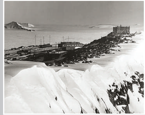
Вид ст. Ленинградская
