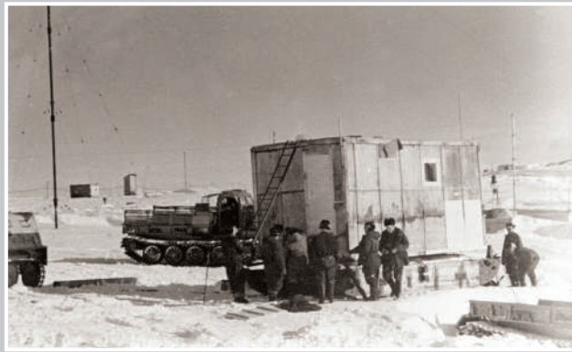
Строительство станции Новолазаревская
