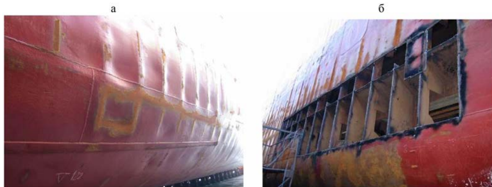
Рис. 1.10. Остаточные деформации (бухтины) (а) и замена листов наружной обшивки в районе миделя (б) (балкер, дедвейт 10900 т, класс IA)
