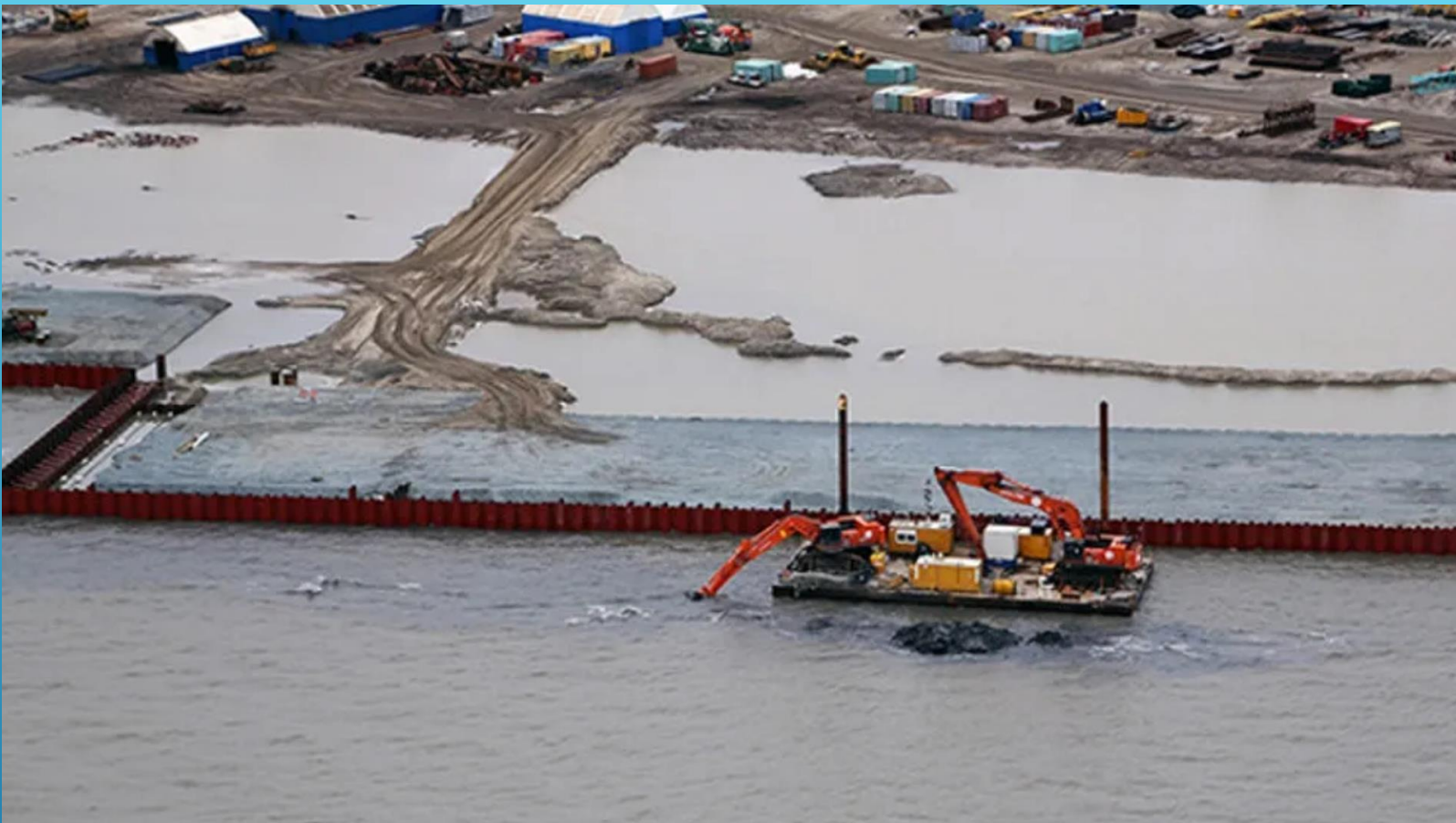
Дноуглубительные работы в Обской губе (Источник: https://sever-press.ru/ )
