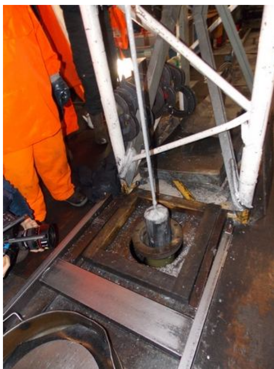
Выход бурового снаряда из скважины
